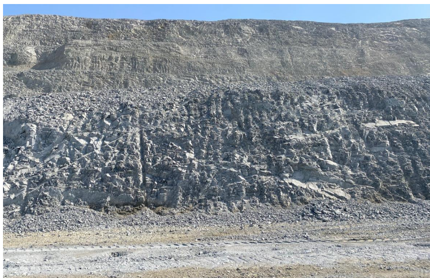
Рисунок 2.19 – Состояния откоса после заоткоски уступа контурного блока 1290005
