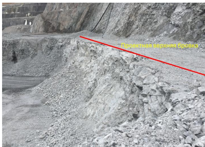
Рисунок 2.14 – Состояния откоса после отработки контурного блока 1290001
