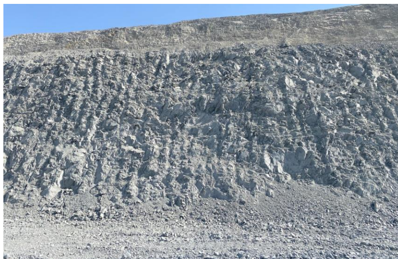
Рисунок 2.18 – Состояния откоса после заоткоски уступа контурного блока 1290004
