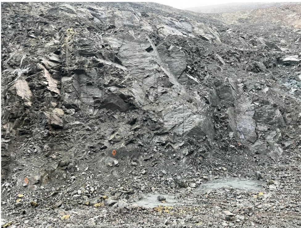
Рисунок 2.9 – Состояния откоса на 2 стадии карьера, до проведения исследования
