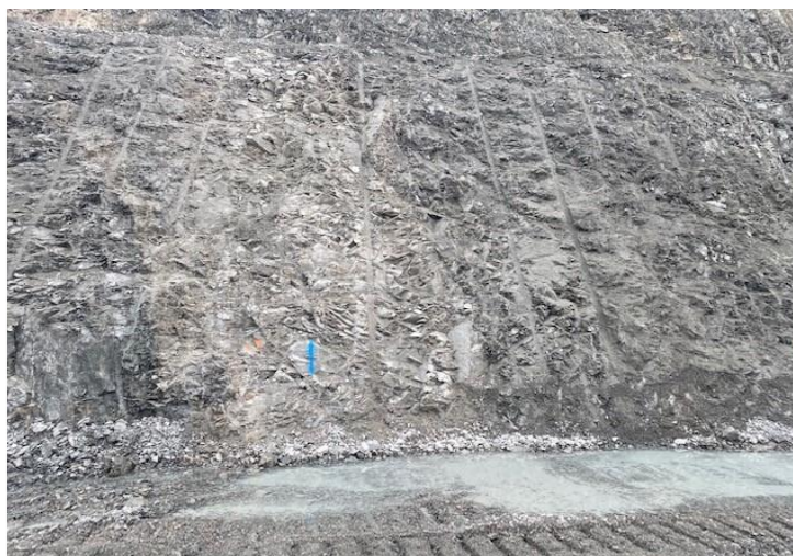
Рисунок 2.16 – Состояния откоса после заоткоски уступа контурного блока 1290002
