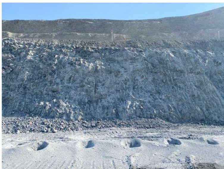
Рисунок 2.17 – Состояния откоса после заоткоски уступа контурного блока 1290003
